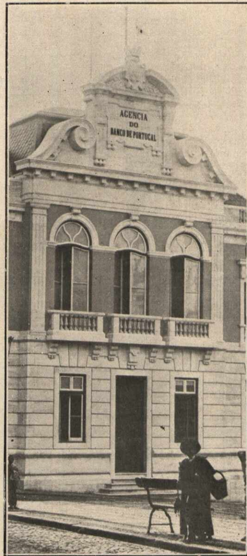
Detalhe da fachada principal
