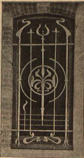
Grade para janella, em ferro forjado
